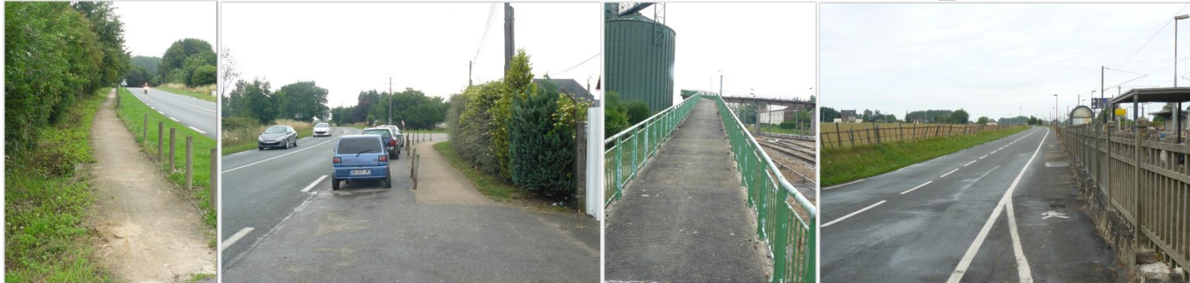
Sente piétonne le long de la RD20 et aménagement au niveau de la gare :
